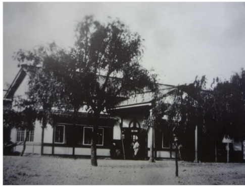
初代 畝傍駅駅舎(1893年・明治26年)
